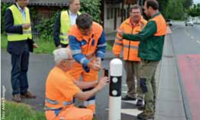
Unter der Aufsicht des kantonalen Wildhüters Steven Diethelm (r) montieren die Mitarbeiter des kantonalen Tiefbauamts einen Wildwarner an einem Strassenpfosten entlang der H8 zwischen Pfäffikon und Schindellegi.
